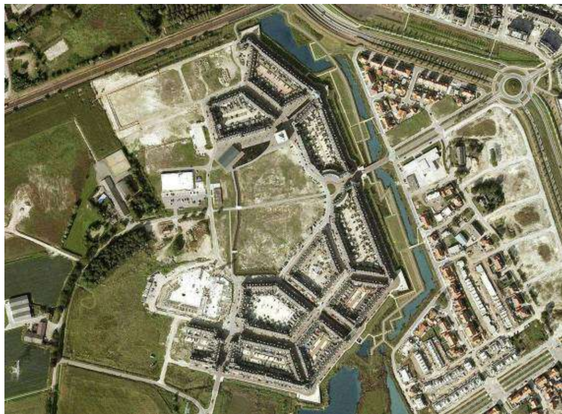
La città di Brandevoort in costruzione / The city of Brandevoort under construction
