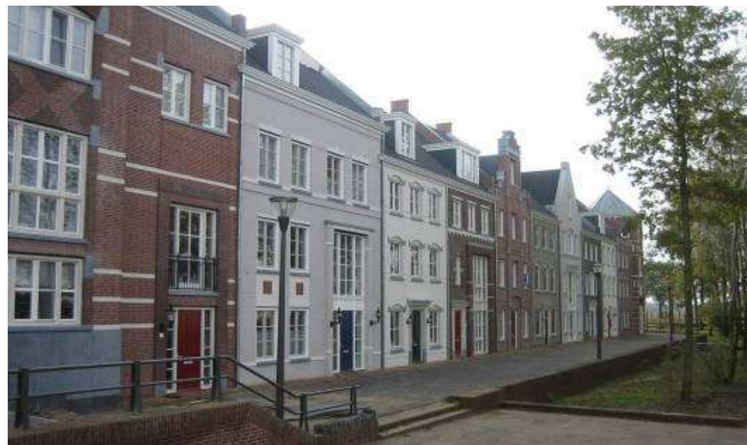
Isolato 18 realizzato, Vista lungo l'Hertogsveld – Block 18 completed, View along the Hertogsveld
