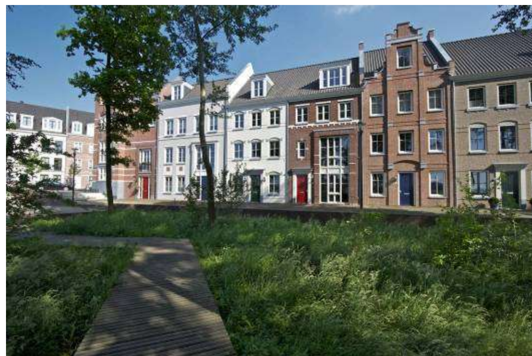
Isolato 18 realizzato, Vista lungo l'Hertogsveld – Block 18 completed, View along the Hertogsveld
