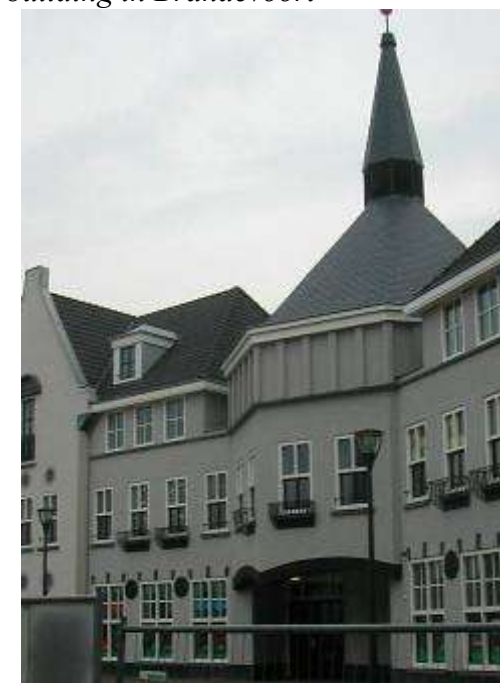
Discutibile soluzione d'angolo in un edificio di Brandevoort, non solo la cortina è tagliata sullo spigolo, ma addirittura non esiste un supporto ai due archi convergenti – Questionable corner solution in a building of Brandevoort. Not only is the curtain cut on the edge, but there is even no support to the two arches converging
