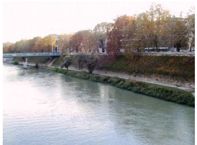
Fig.6 –La pista ciclabile vista da Ponte Matteotti
